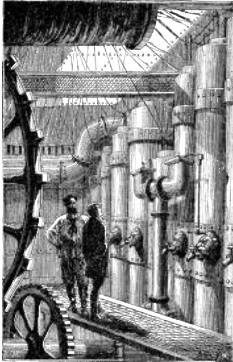
La camera delle macchine rischiarata splendidamente (pag. 155).
